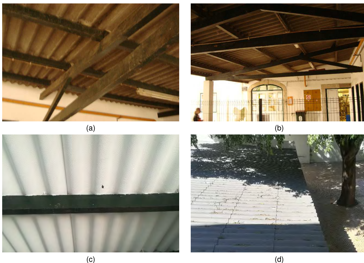
Figura 6.29 – Telheiro junto ao refeitório com cobertura de fibrocimento: situação em 2018-10-23 (a) e (b); situação em 2019-05-30 (c) e (d)
