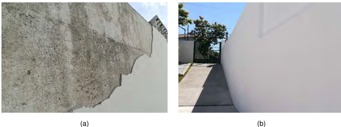
Figura 6.54 – Reboco do muro divisório com a moradia contígua: situação em 2018-10-11 (a); situação em 2019-05-30 (b)
