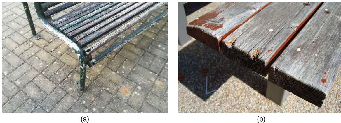
Figura 5.49 – Exemplos de bancos danificados: JI da Ameixoeira (a); e EB das Galinheiras (b)
