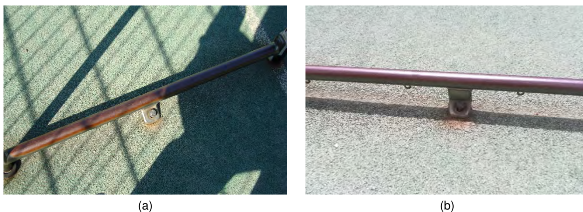
Figura 6.10 – Fixação de baliza ao solo: situação em 2018-09-11 (a); situação em 2019-05-21 (b)
