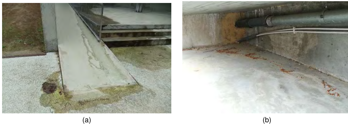
Figura 6.32 – Zona do pátio do JI: situação em 2018-10-25 (a); situação em 2019-05-21 (b)
