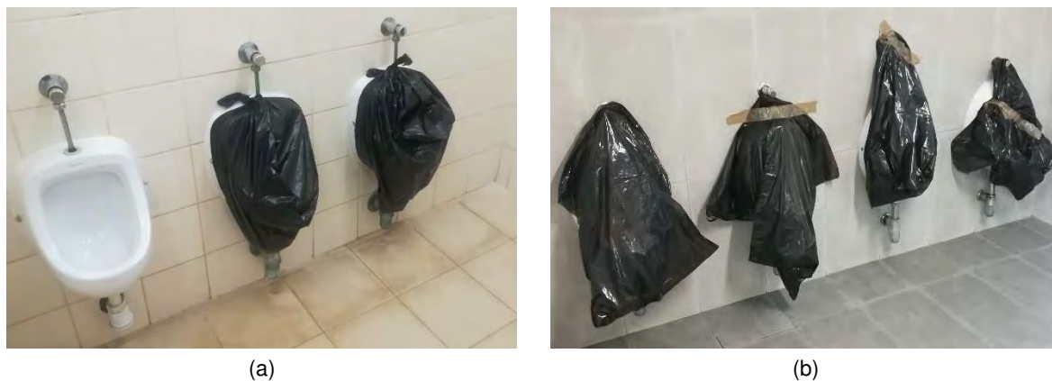
Figura 5.30 – Exemplos de urinóis desativados: EB das Laranjeiras (a); EB Parque Silva Porto (b)
