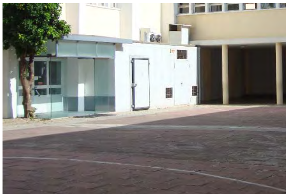
Figura 6.12 – Porta envidraçada, contígua a recinto do campo de jogos: situação em 2018-09-20
