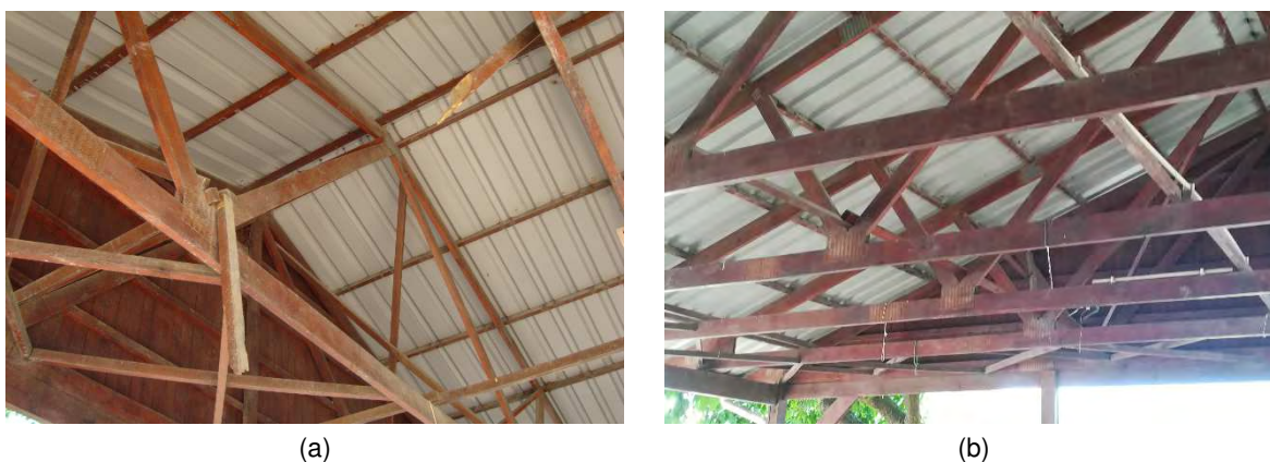
Figura 6.65 – Asnas de madeira do edifício do CAF: situação em 2018-10-11 (a); situação em 2019-05-21 (b)
