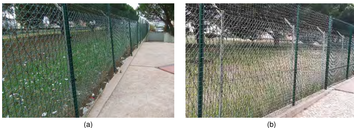
Figura 6.31 – Vedação metálica: situação em 2018-10-25 (a); situação em 2019-05-21 (b)
