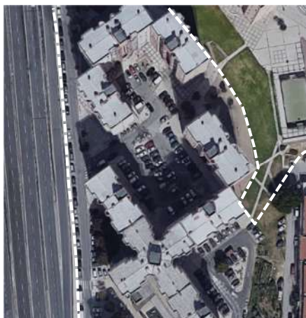
Figura 7: Fotografia aérea do Bairro do Casal dos Machados, contrastando o espaço verde qualificado a nordeste com o ambiente urbano no interior do conjunto edificado e a sudeste, no limite da Rua Vasco da Gama Rodrigues. A tracejado banco, o limite da ARU proposta.
