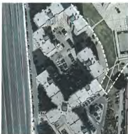
Figura 7: Fotografia aérea do Bairro do Casal dos Machados, contrastando o espaço verde qualificado a nordeste com o ambiente urbano no interior do conjunto edificado e a sudeste, no limite da Rua Vasco da Gama Rodrigues. A tracejado branco, o limite da ARU proposta.
