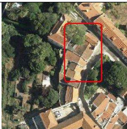
Vista aérea da construção (Fonte: MapSnapshot.jpg)
