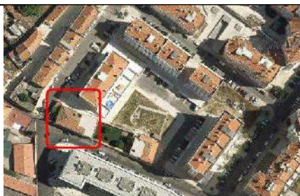
Vista aérea da construção (Fonte: MapSnapshot.jpg)
