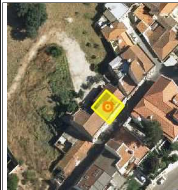
Vista aérea da construção (Fonte: MapSnapshot.jpg)
