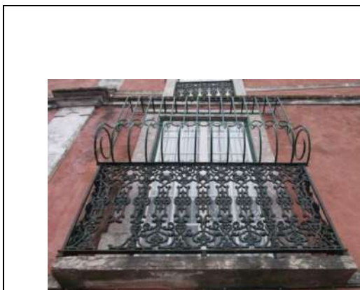
Estrada da Ameixoeira/ Guarda de ferro fundido; Elementos de cantaria
