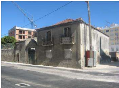
Perspetiva da fachada do edifício principal – Rua de São Bartolomeu (Fonte: 0501903010001h_1.jpg)
