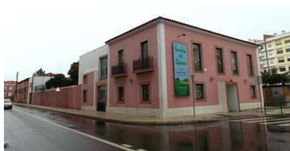
Vista de conjunto [Jan. 2016]
