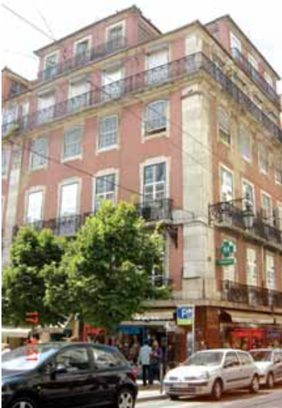
Fig. 16 – Rua dos Fanqueiros, 243-249/Rua de Santa Justa, 48. Exemplo de edifício com fachada pombalina, cobertura e caixa de escada neoclássicas.
