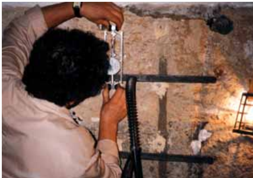
Fig. 5 – Edifício da Baixa Pombalina.
