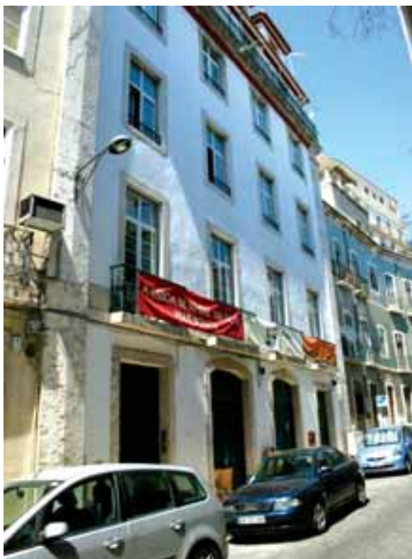
Fig. 6 – Edifício reabilitado, na Rua do Ferragial, 32 a 34.
