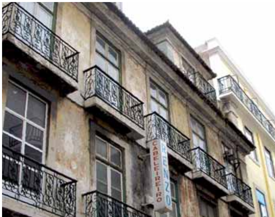
Fig.14 – Pormenor do alçado, Rua Anchieta.
