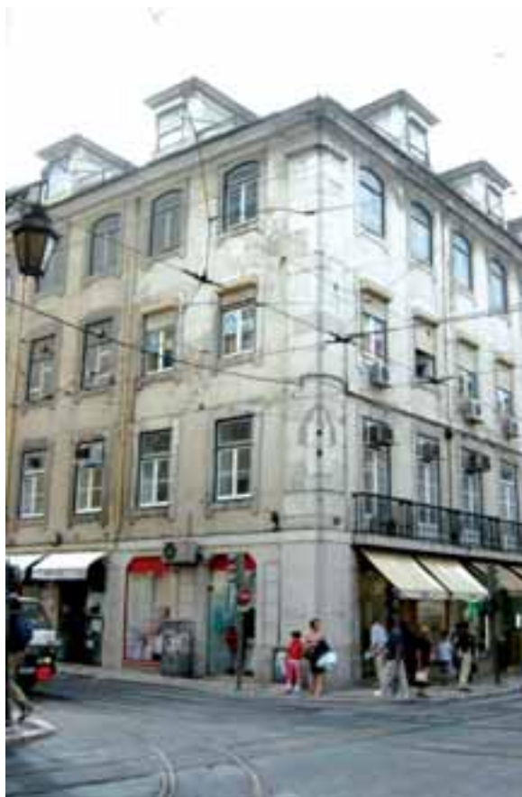
Fig. 15 – Rua da Conceição, 51-61/Rua da Prata, 52-66 Exemplo de edifício com fachada pombalina, cobertura e escada pombalinas.
