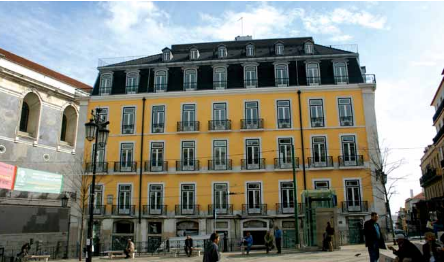
Fig. 12 – Hotel Poeta, no Chiado, após a realização da obra.
