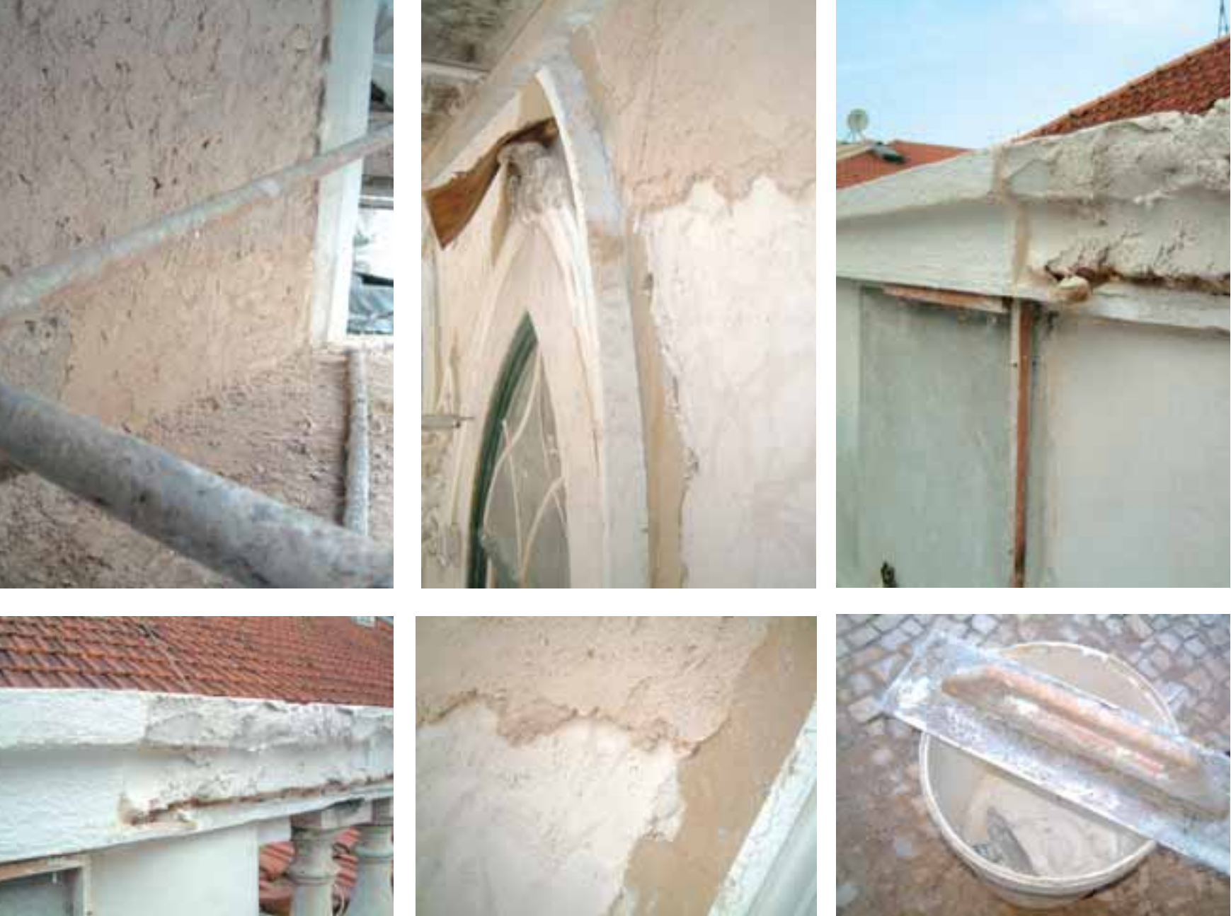
Fig. 27 – Aplicação de revestimentos aéreos.
