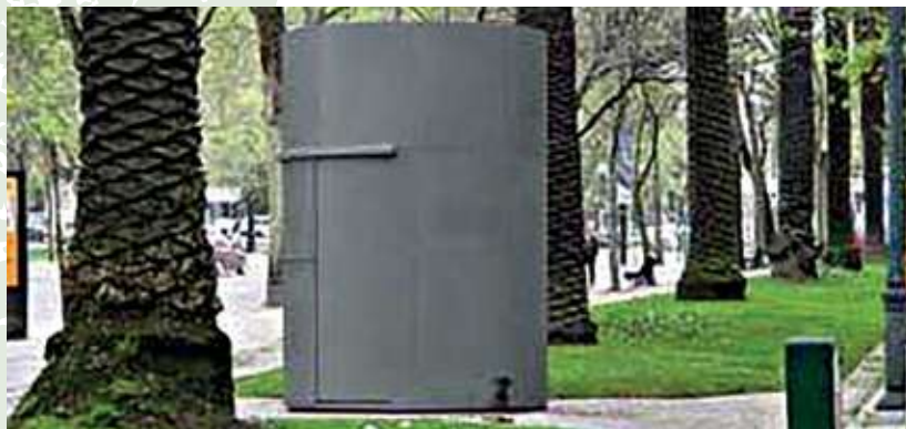
Estação de monitorização da qualidade do ar, na Avenida da Liberdade, Lisboa.
