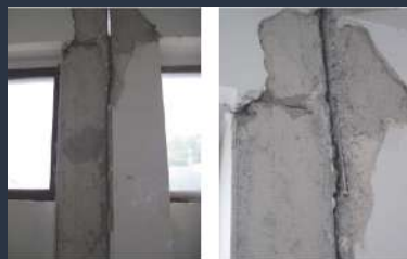
School building in via Duca degli Abruzzi, L' Aquila
