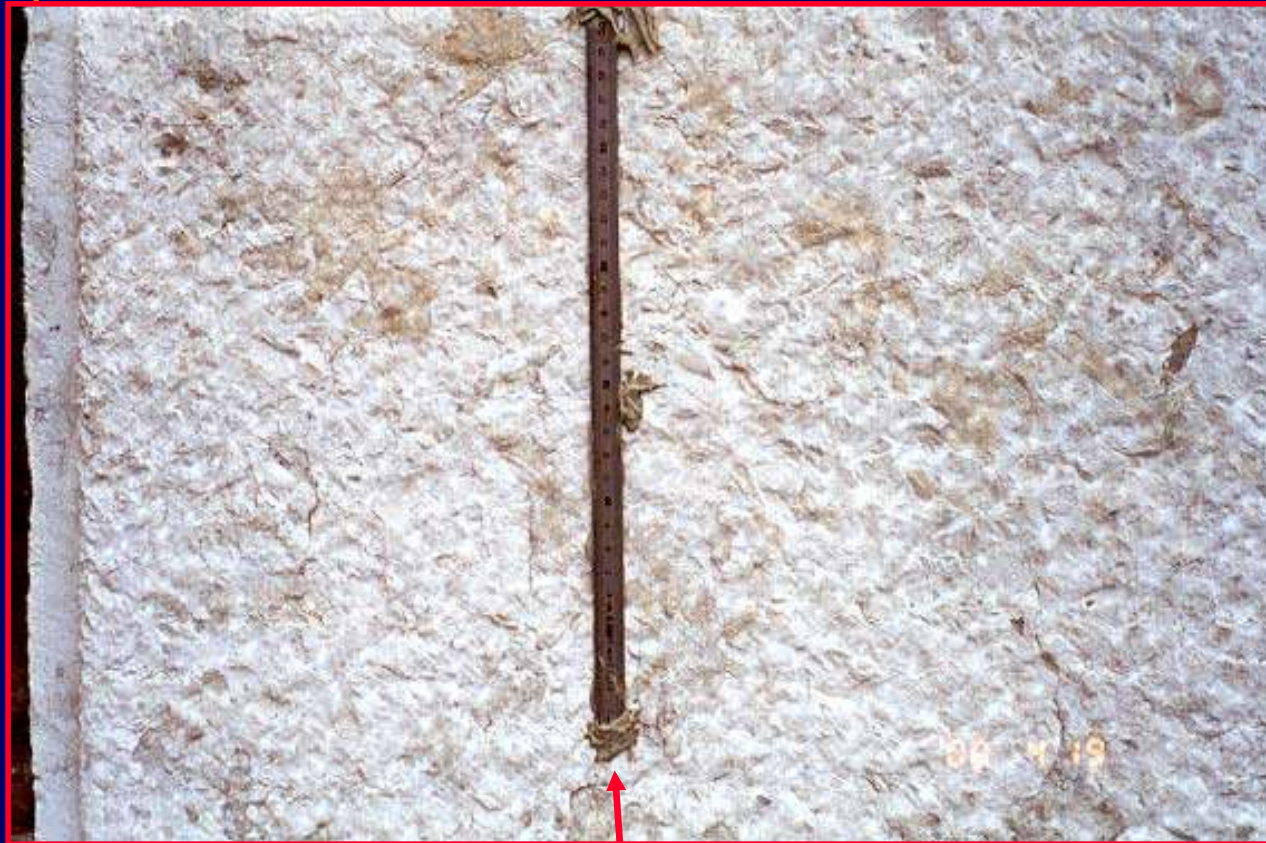
Régua topográfica em fachada de edifício
