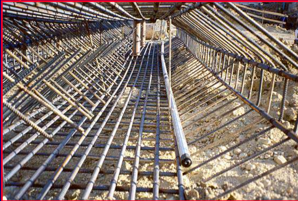
Montagem de calha inclinométrica
