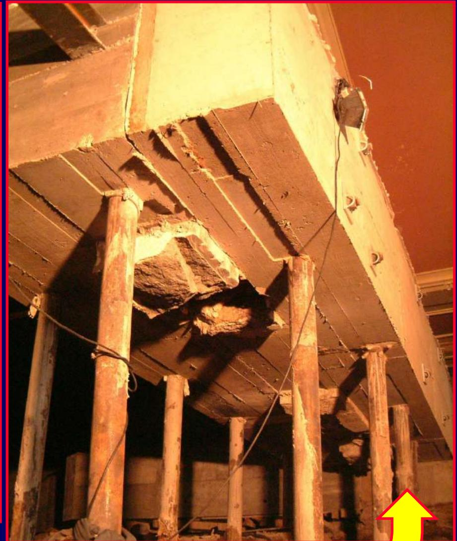
**Microestacas utilizadas nas soluções de recalçamento**
