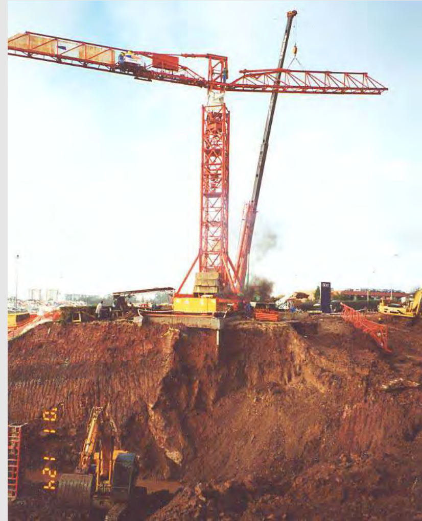
Reforço sísmico de fundações de alvenaria, Lisboa 26 de Outubro de 2022
