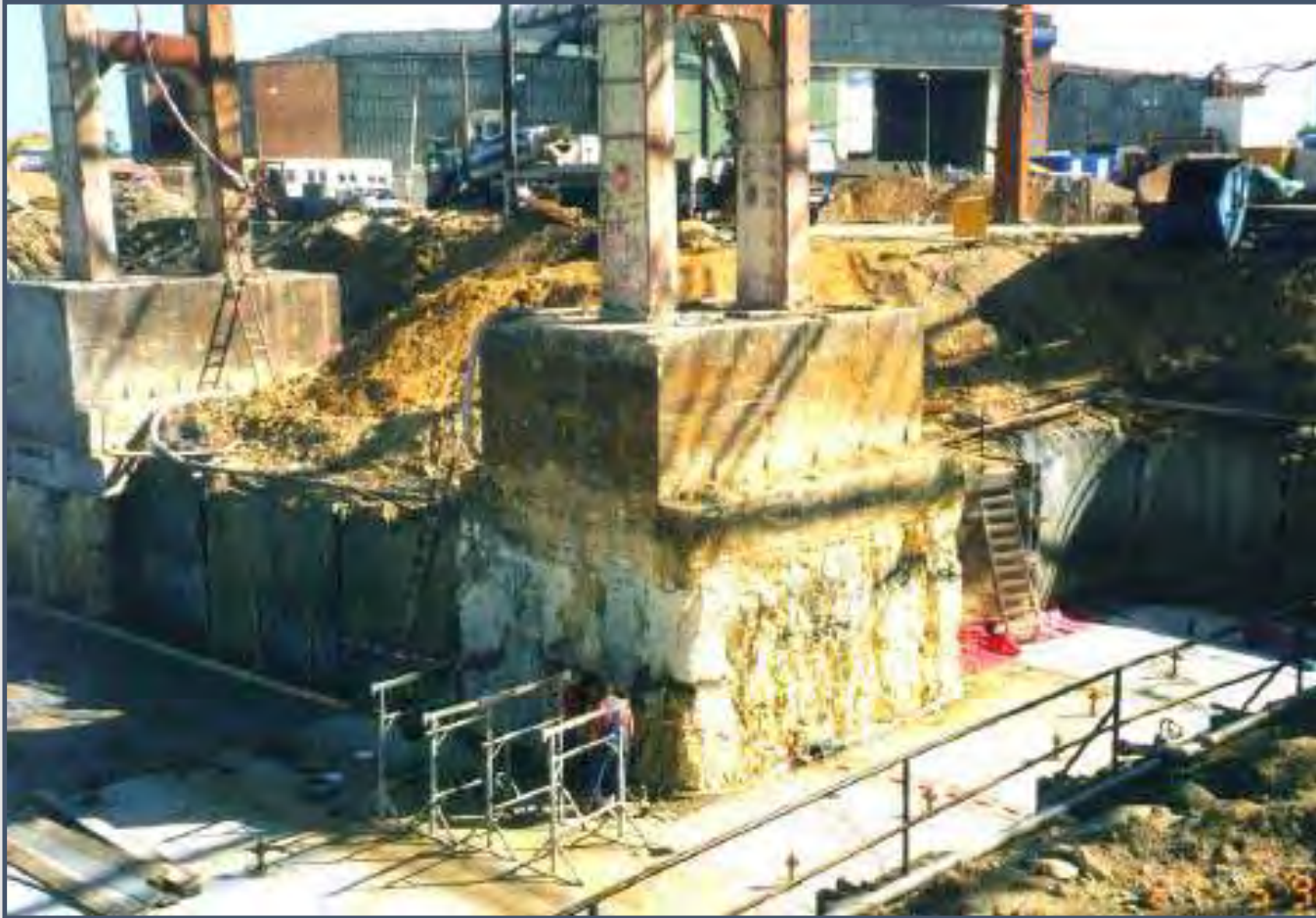
Reforço sísmico de fundações de alvenaria, Lisboa 26 de Outubro de 2022
