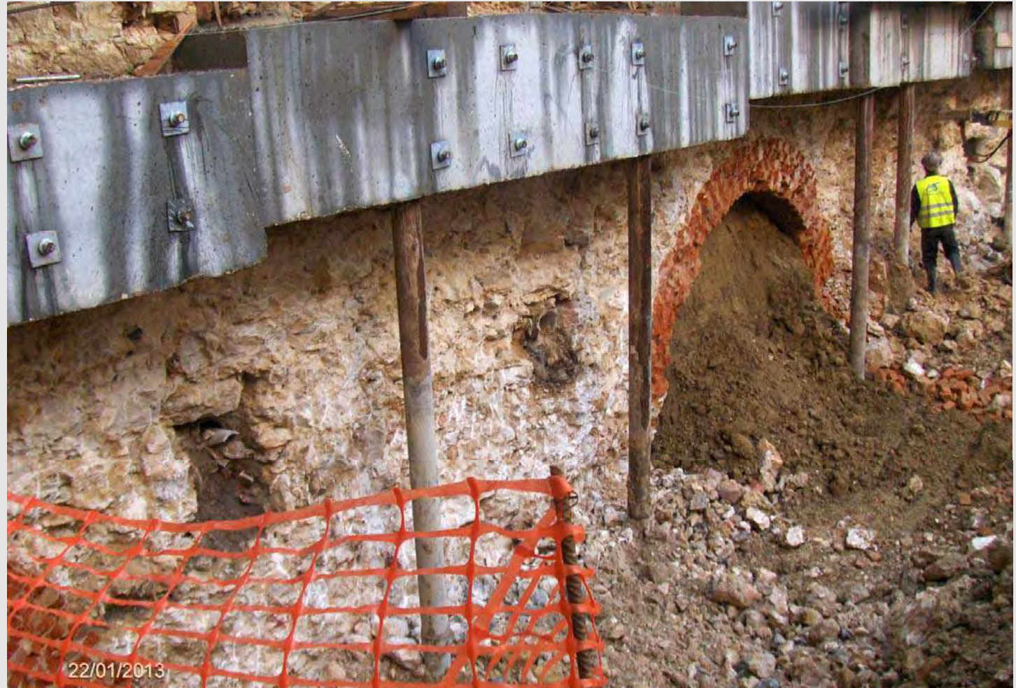
Reforço sísmico de fundações de alvenaria, Lisboa 26 de Outubro de 2022
