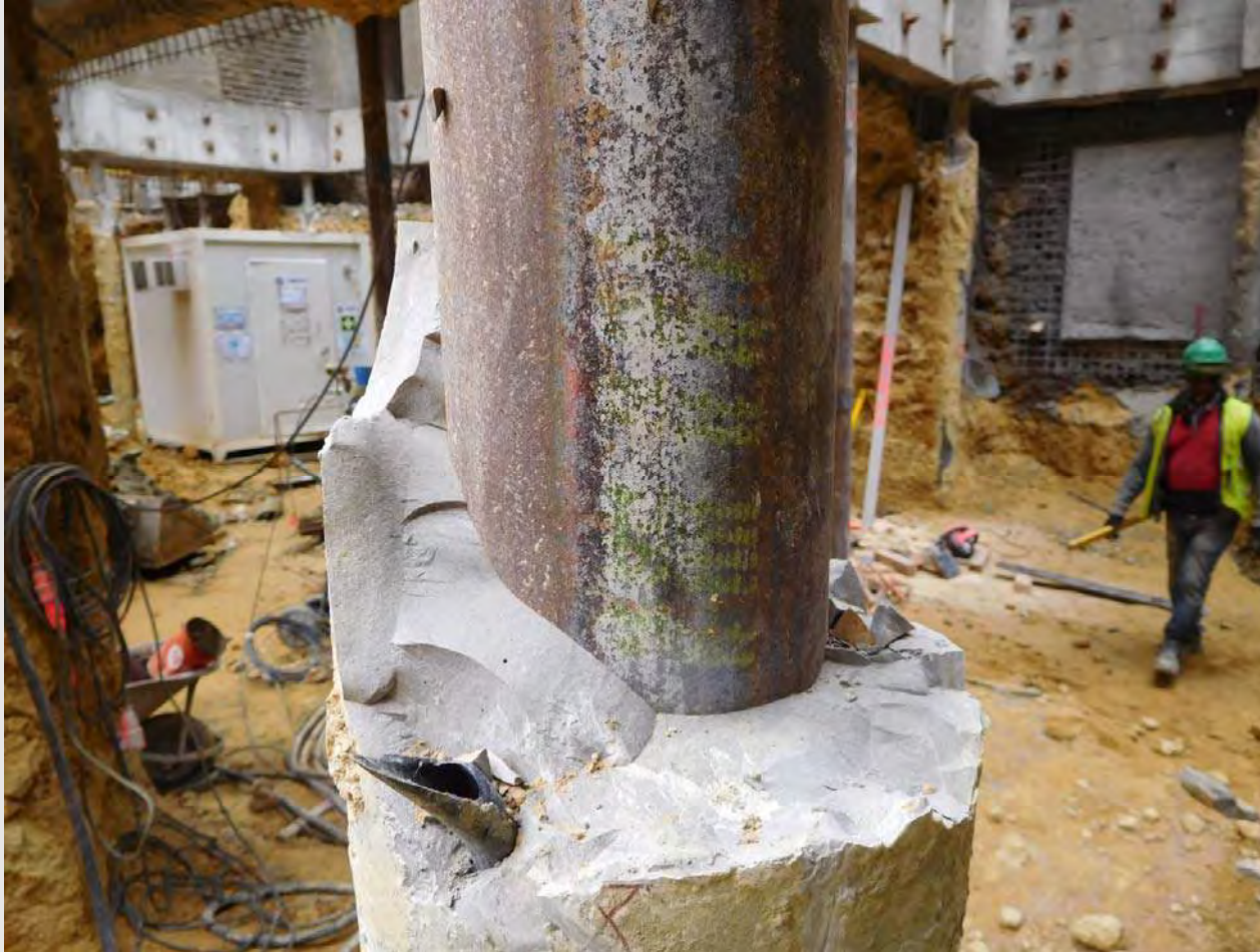
Reforço sísmico de fundações de alvenaria, Lisboa 26 de Outubro de 2022
