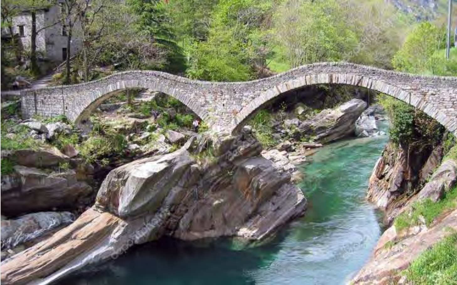
Ponte Vale Verzasca, Suíça
