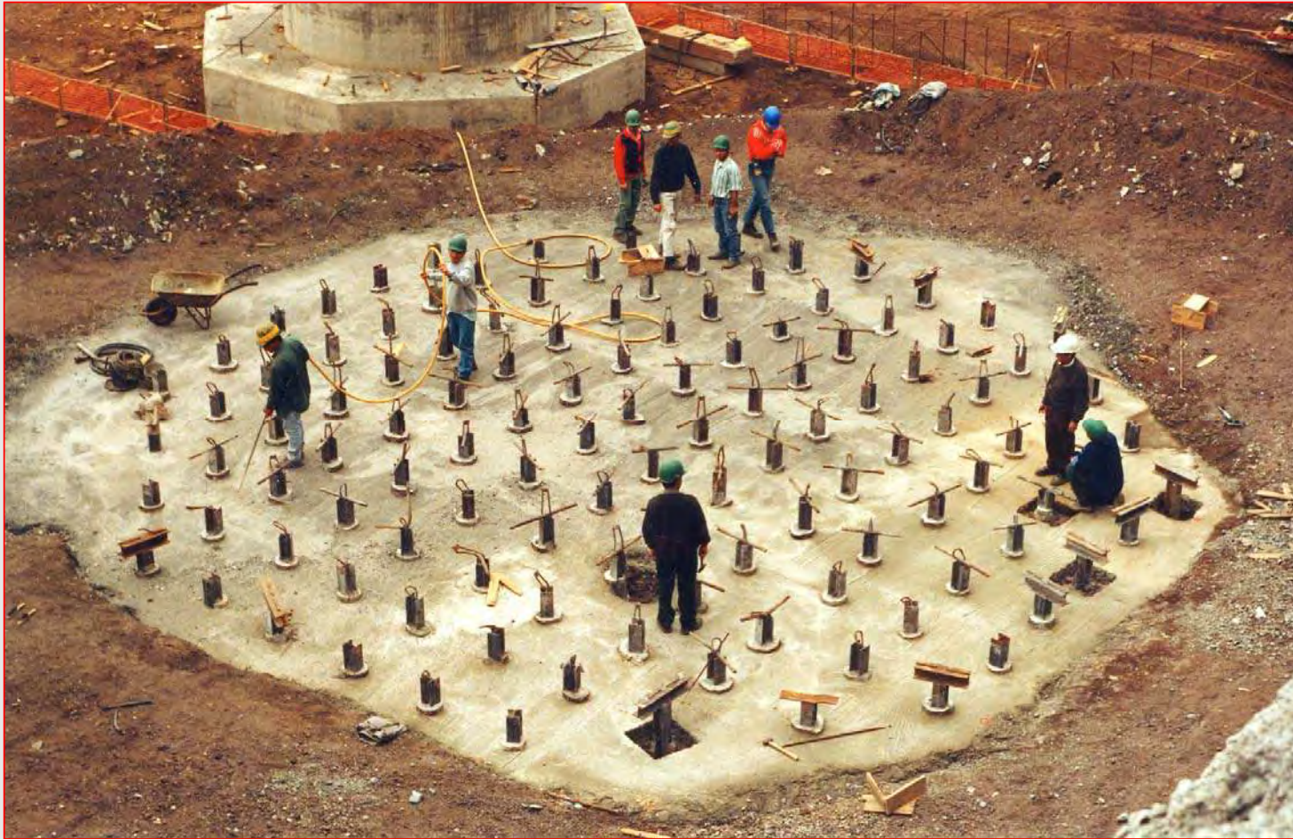
Reforço sísmico de fundações de alvenaria, Lisboa 26 de Outubro de 2022
