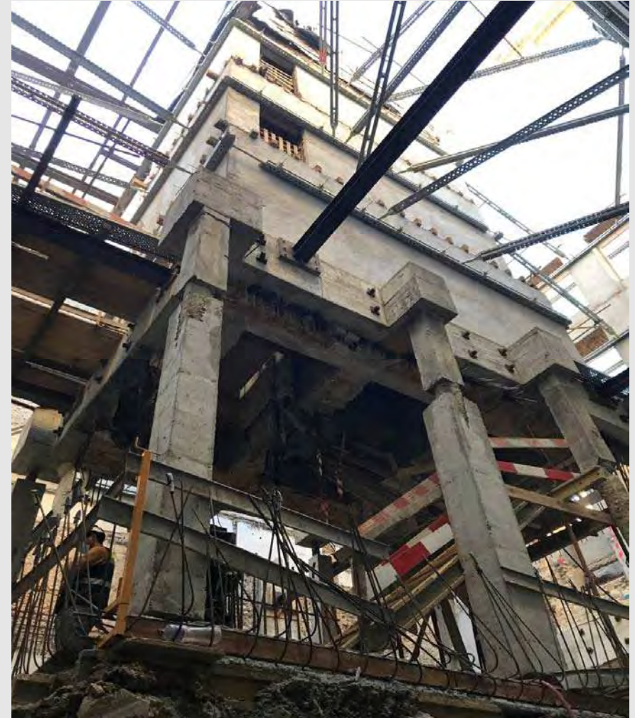
Reforço sísmico de fundações de alvenaria, Lisboa 26 de Outubro de 2022
