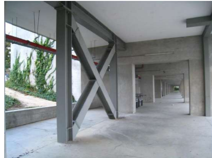
Novas estruturas metálicas de travamento (trianguladas)
