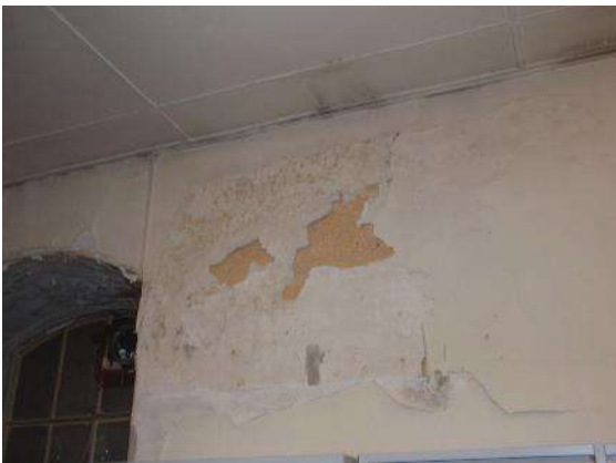
(Desagregação do reboco (Ed.2) e parede (Ed.3), com humidade generalizada em paredes)
