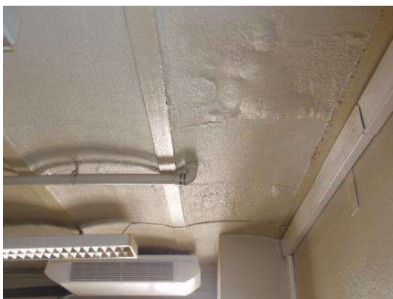
Descarga em cachorro com fendilhação (Ed.3) | Infiltrações em abobadilhas
