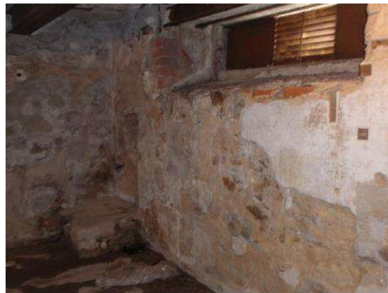
(Desagregação do reboco (Ed.2) e parede (Ed.3), com humidade generalizada em paredes)
